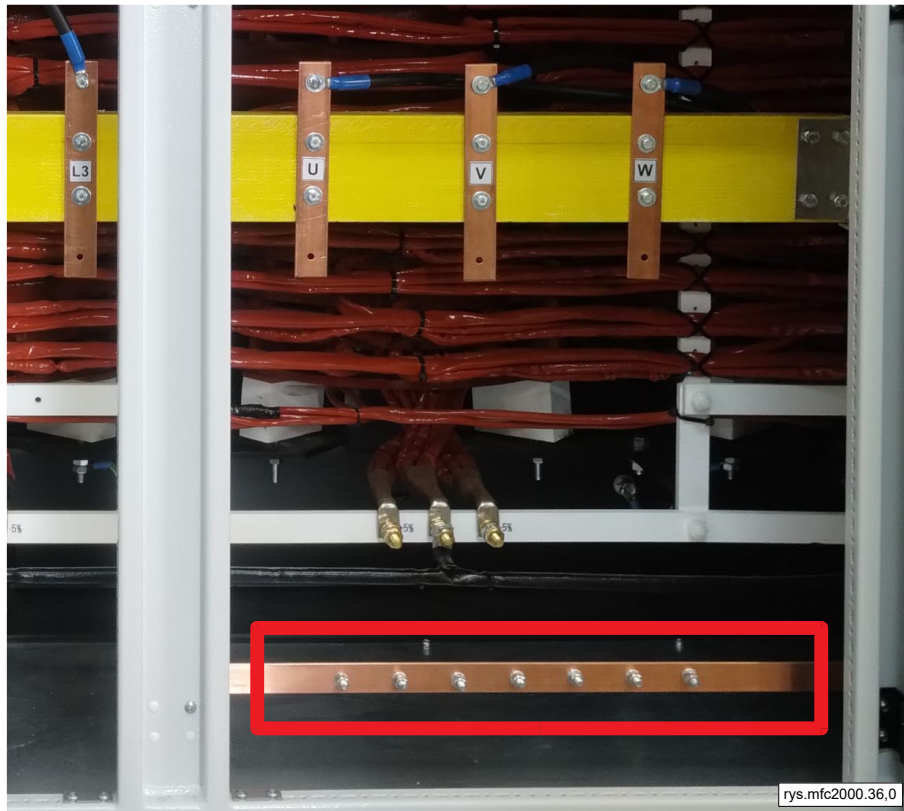
Rys. 29. Szyna PE
