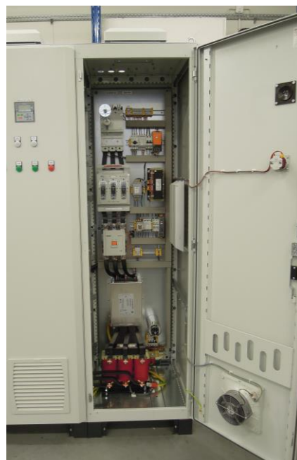
Rys. 17. Przekształtnik BSI 250 o mocy 250 kW dedykowany dla przemysłowego magazynu energii
